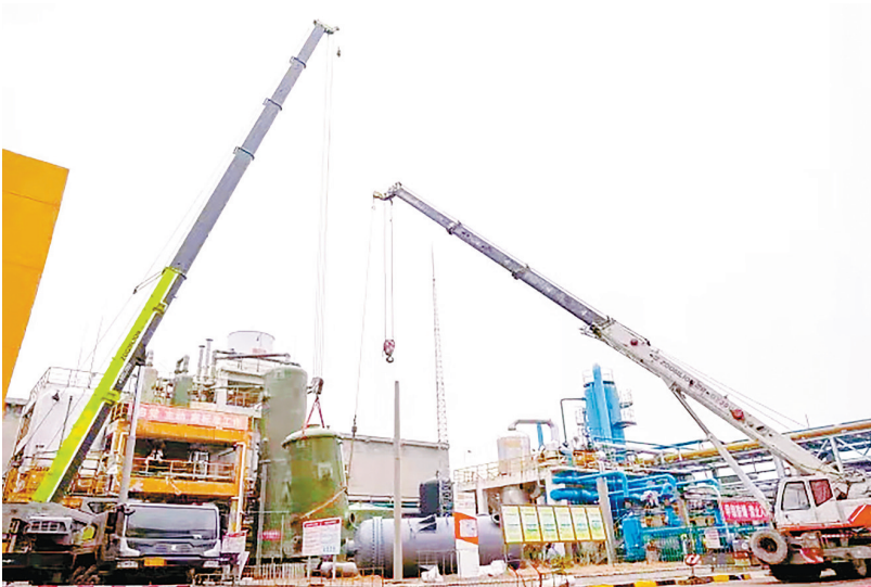
氯碱装置酸雾捕集器和水雾捕集器更换施工现场。
