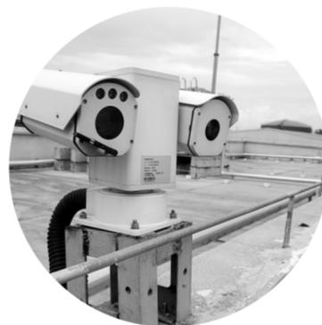
业,智能机器人巡检,410个微型摄像头对现场设备状态实时精准监测,5000余个巡检点位数据采集并自动比对,对架空绝缘子缺失及线路下方异物入侵准确识别,实现了220千伏“浙炼变”的无人值守。
