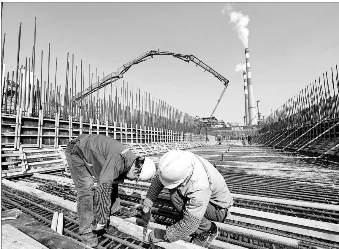
仪征化纤300万吨/年PTA项目进行土建施工
