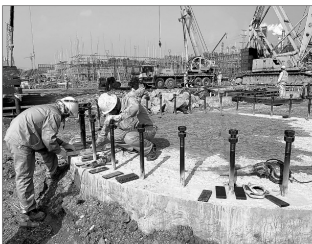
安庆石化“油转化”项目进入安装阶段
