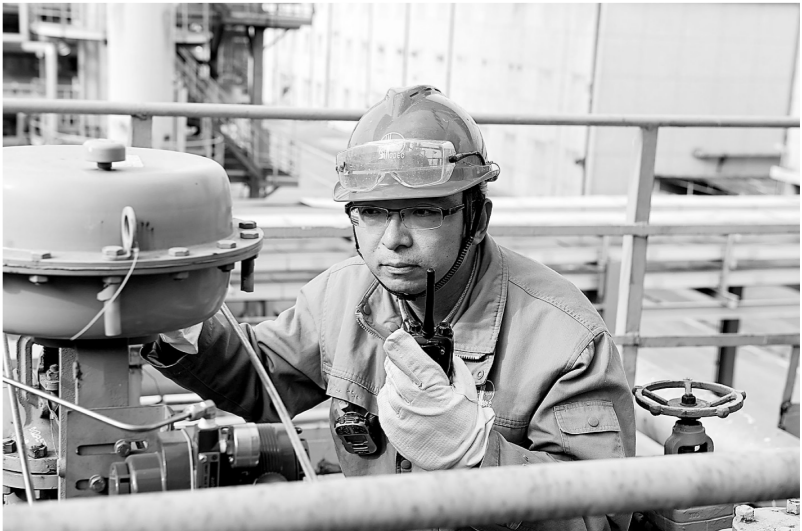
图为陈玉东对氮气阀的阀位进行核。 周晓琪 摄
