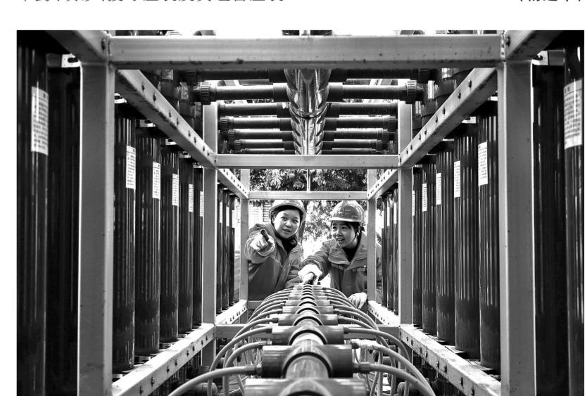
西南油气采气一厂持续开展工艺技术优化,采用“膜减量+蒸馏”联合工艺,实现川西中浅层泡排水达标排放。截至目前,该站已累计处理气田地层水近190万立方米,为川西气田绿色开发做出积极贡献。图为员工巡查膜减量超滤装置运行情况。
