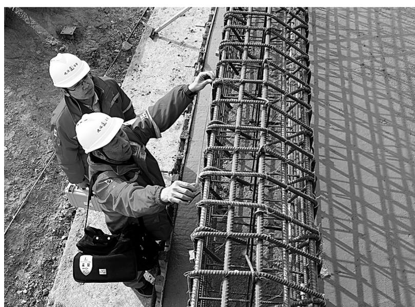
胜利油田近期开展东营原油库迁建工程专项检查,对储罐基础的钢筋绑扎、环氧施工等关键工序、重要节点进行抽检,同时进一步核查监理责任的落实情况,确保工程安全整体受控,工期按计划运行。图为2月9日,监督人员测量储罐环筋的绑扎安全间距。王国章 摄 聂燕飞 摄
