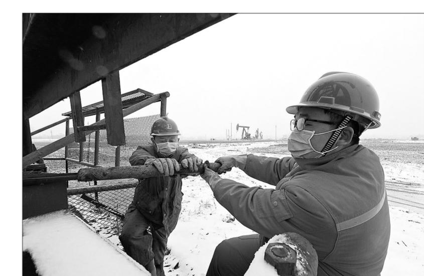
1月21日，河南油田百里油区大雪纷飞。采油一厂启动极端天气应急预案，加大抽采设备巡检次数，排查“松动断脱”隐患，做好防冻防堵措施，全力保障原油生产安全平稳运行。图为采油员工紧固H3-507井抽油机螺丝。
