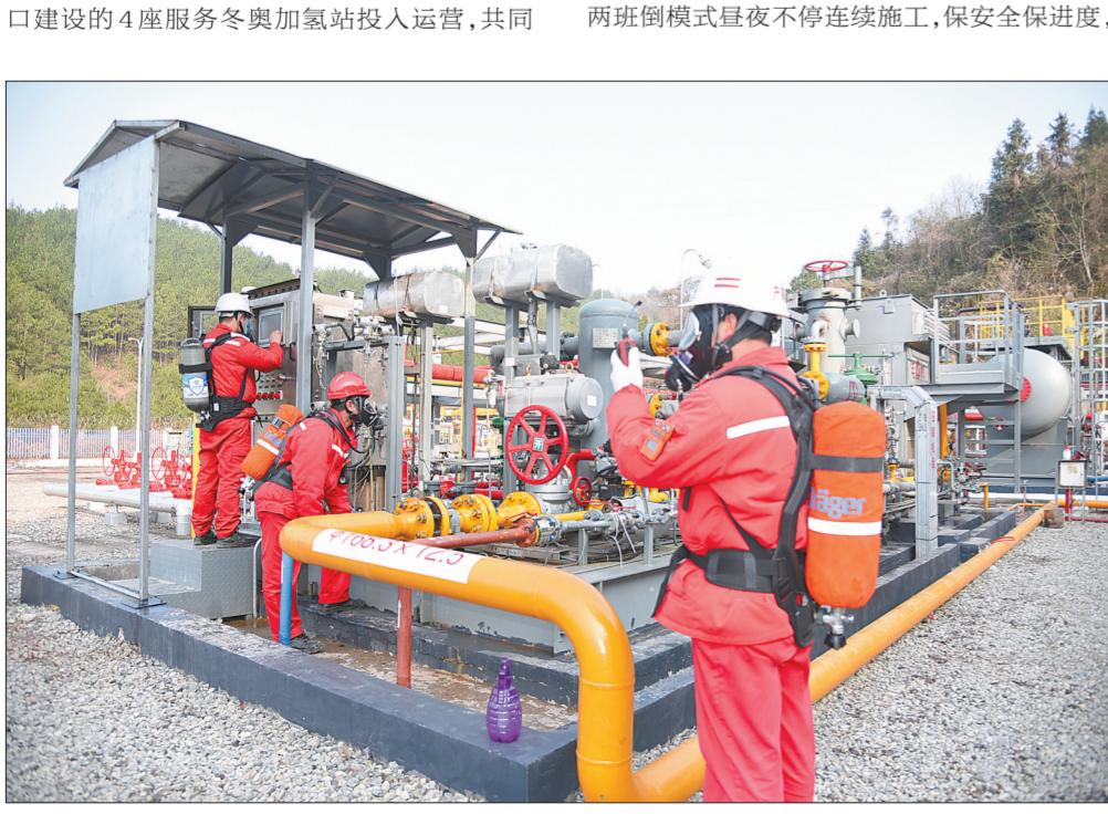
为延长高含硫气田开发稳定周期,提高采收率,集团公司将高含硫气田增压技术纳入重大科技攻关项目。1月10日,首台国产高含硫天然气增压压缩机先导试验在普光气田101集气站进行,在72小时内对压缩机进行最大气量工况、设计工况、功率工况试验,取得圆满成功。图为试验现场。
