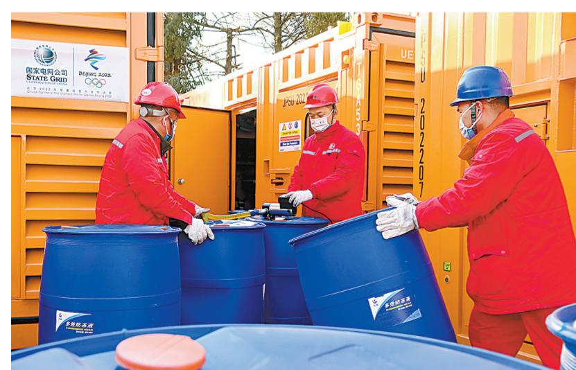
日前,中原油田供电服务中心北京2022年冬奥会保电项目组工作人员,在北京市顺义区项目工地,为移动式柴油发电机加注长城润滑油和防冻液。这些柴油发电机将为国家体育场、延庆冬奥场馆、首都体育馆等冬奥会比赛场馆提供电力保障服务。图为项目组工作人员,为即将被送往延庆冬奥场馆的移动式柴油发电机加注防冻液。
