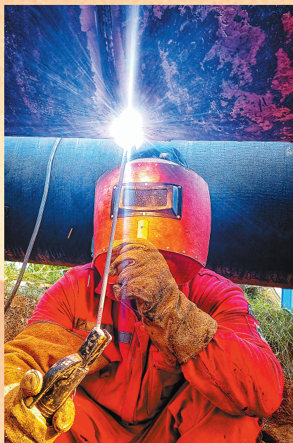
中原油田员工在承建的卫11储气库站外管道进行管口焊接作业。 赵要松 摄
