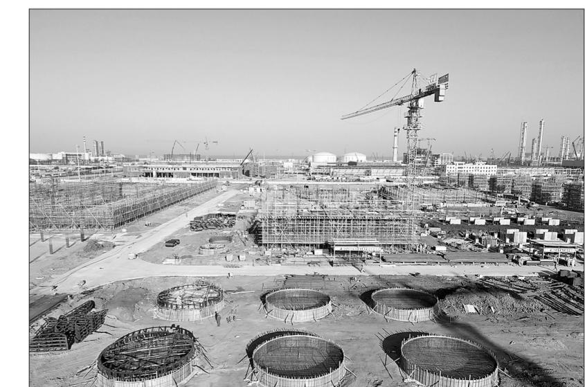
12月14日,五建公司承建的海南巴陵化工新材料有限公司17万吨/年苯乙烯类热塑性弹性体项目顺利推进,目前主单元地下基础工程已完工,上部施工进入脚手架搭设、钢筋安装阶段,土建工程完成40%。图为施工现场。
