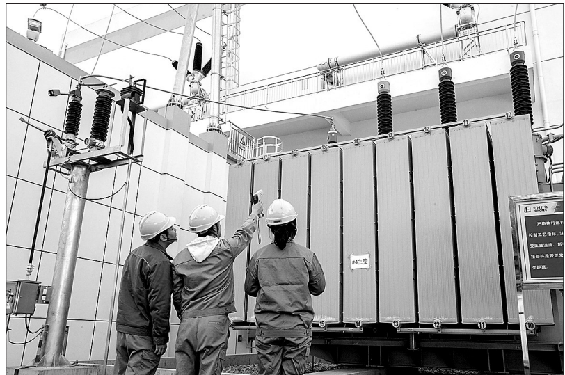
扬子石化热电厂电气车间聚焦冬季安全生产,成立特巡小组,对变压器冬季重要参数油温及油位增加巡检频次,手指口述操作确保精准无误。图为12月10日特巡小组巡查变压器关键部位。李树鹏 摄 余金涛 文
