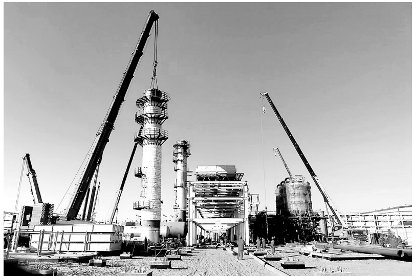
12月2日,在西北油田顺北联合站第二套天然气处理装置工程现场,吸收塔和再生塔两座百吨塔器顺利吊装到位,标志着顺北重点工程项目建设进入攻坚阶段。 陈俊锋 摄
