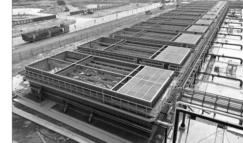
近日,炼化工程集团宁波工程公司EPC总承包的海南炼化乙丙项目净化水装置进入试生产。该装置历时8个月建成,具有占地小、易施工、分批次投运、自动化程度高等特点,出水水质不但能满足工业生产用水需要,还可作为生活饮用水。图为装置模块化净水设备。
