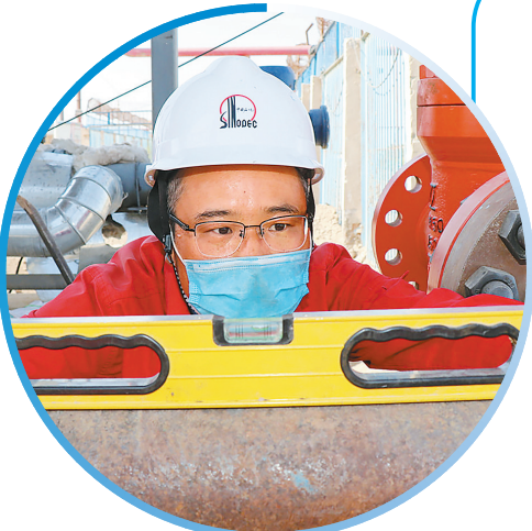
张顺邦用水平尺测量阀门管线水平度。
