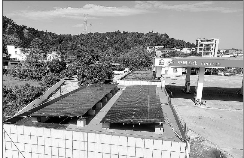
11月25日,广东肇庆石油在山咀加油站建成第一座分布式光伏发电站。该站利用员工宿舍屋顶铺设光伏板,年发电量可达3.41万千瓦时,不仅供加油站日常使用,余电还可以返供电网。图为该发电站现场。
