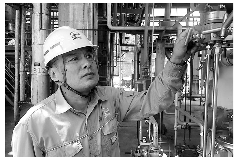
图为梁雪迎巡查装置运行状况。
