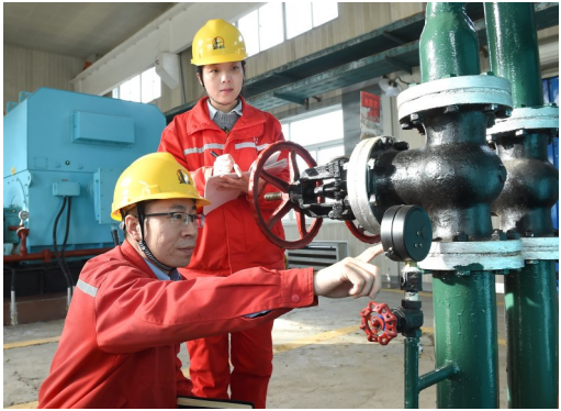
今年以来,江汉采油厂通过低效注水泵治理、优化回灌系统运行、加强管线清洗等措施,注水系统单耗同比降低7.7个百分点。图为11月22日,该厂工艺技术人员检查记录注水泵机组运行参数。李东勇 王 燕 摄影报道
