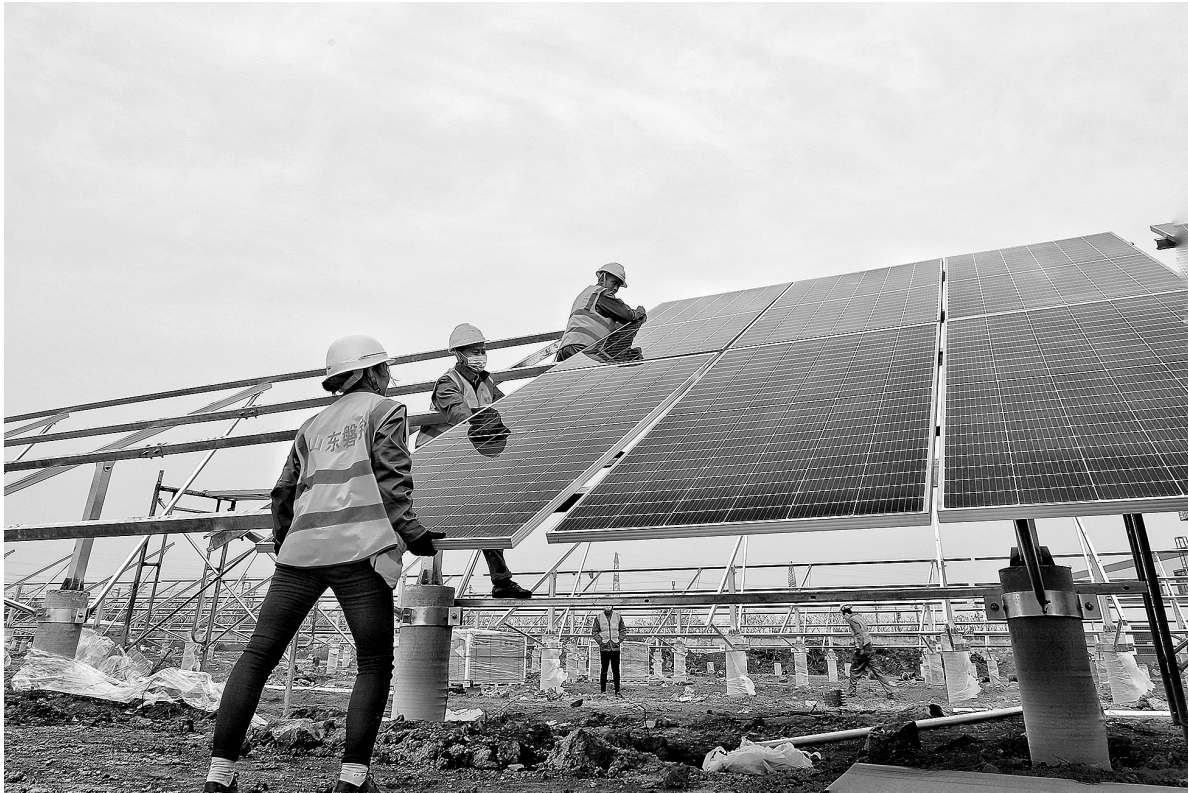
齐鲁石化光伏发电项目开始设备安装
