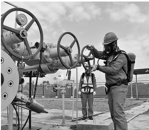
11月16日,中原油田普光分公司采气厂完成M504-502管段空穴射流施工,有效解决硫沉积问题,使M504-1H等井恢复生产,瞬时气量从108万立方米/日提高到120万立方米/日。 梁晓芸 摄
