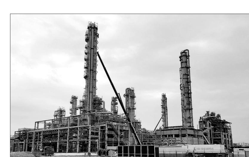
11月中旬以来,炼化工程十建公司承建的福建联合石化EO/EG(环氧乙烷-乙二醇联合装置)项目检修全面展开。目前十建公司已完成阀门检修更换18台、塔盘拆除151层、设备拆除返厂26台等施工任务,施工安全、质量、进度处于受控状态。图为装置检修改造现场。(田元武 摄)
