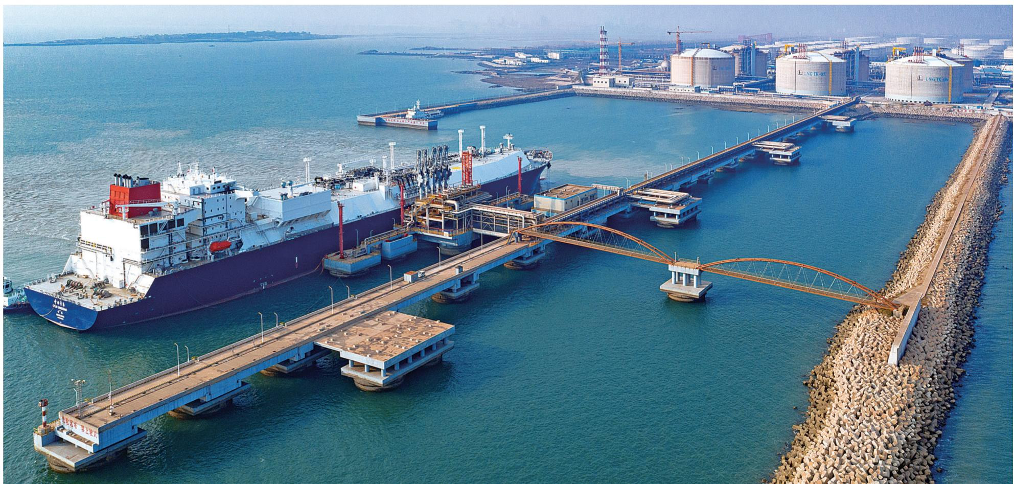
“中能青岛”油轮在天然气分公司青岛LNG接收站码头靠岸卸货。该接收站具备接卸世界上最大的26.6万立方米LNG船的通航条件。
