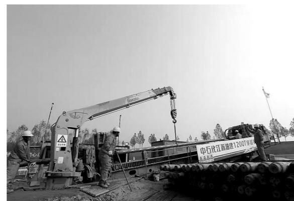
在山东管网南干线天然气管道工程黄河定向钻穿越工程建设中,天然气分公司山东管道始终坚持黄河流域生态保护,采取大堤帮宽加高、临河侧堤坡防护等措施,加大黄河堤岸防护力度。图为11月19日施工场景。
