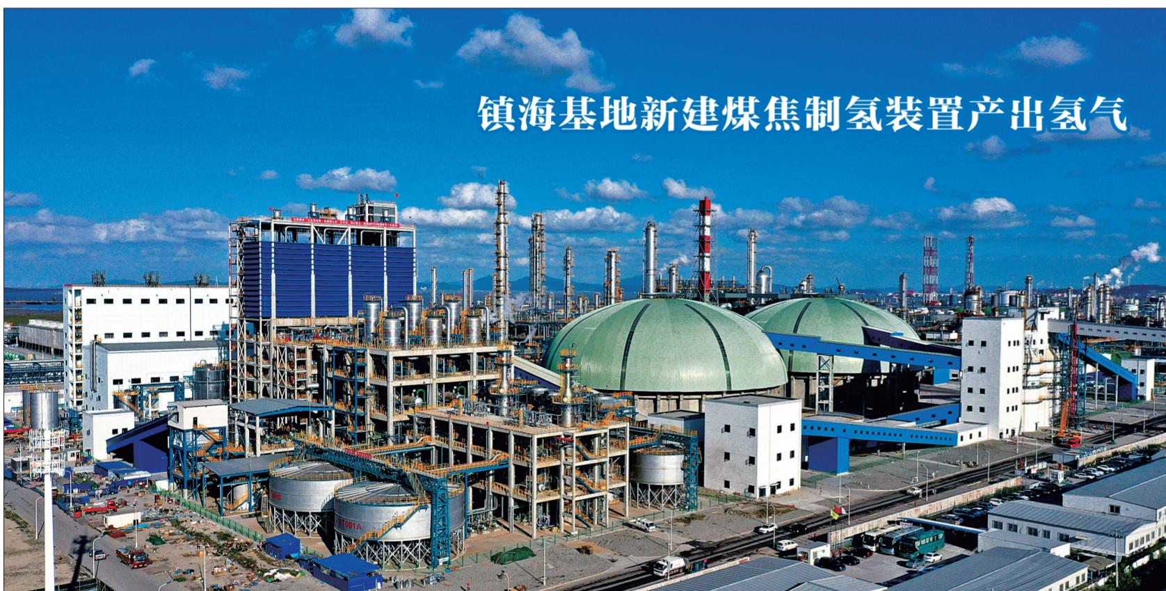
11月19日，镇海基地新建煤焦制氢装置打通全流程，产出合格氢气，从投料开车到产品检验合格，仅历时11小时。该装置由炼化工程集团宁波工程公司EPC总承包，于2020年3月开工建设，采用中国石化SE水煤浆气化技术，以石油焦和煤为原料生产氢气。图为镇海基地煤焦制氢装置全景。本报记者 张见明 摄 卞江岐 文
