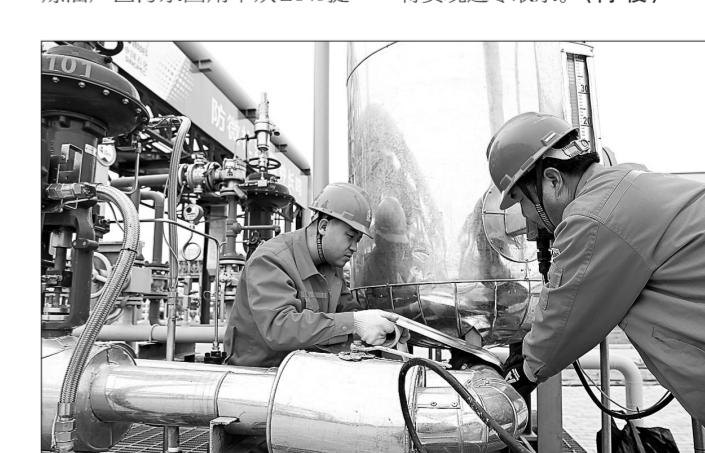
华北油气分公司东胜气田本着早行动、早防范、早落实的原则，全面开展冬季保温工作。针对当地冬季降温快、时间长、气温低的特点，未雨绸缪，有针对性地进行冬防保温。图为10月19日，采气二厂天然气处理厂员工对天然气运行装置进行冬防保温。
