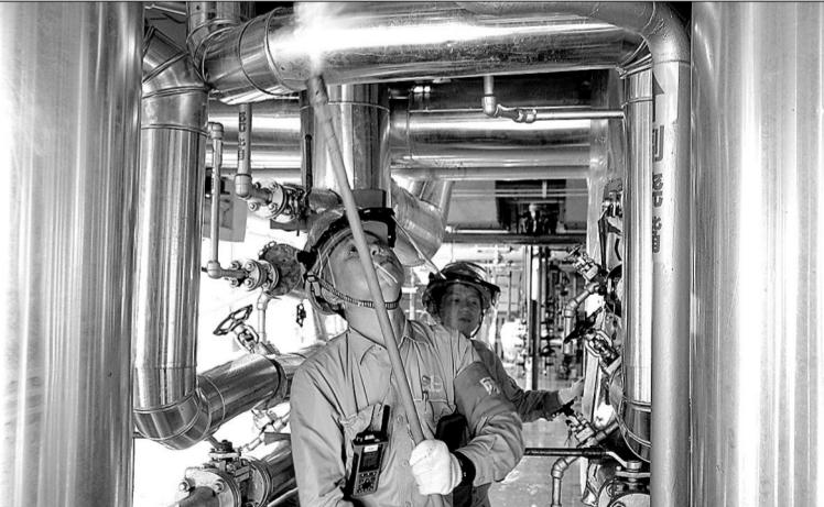
10月16日,镇海基地2号乙烯装置9号裂解炉点火烘炉一次成功。2号乙烯装置共有9台裂解炉,继9号裂解炉点火后,7号、8号裂解炉也陆续进行点火烘炉,共同进入为期9天的烘炉期。图为操作人员对9号裂解炉进行点火烘炉。
