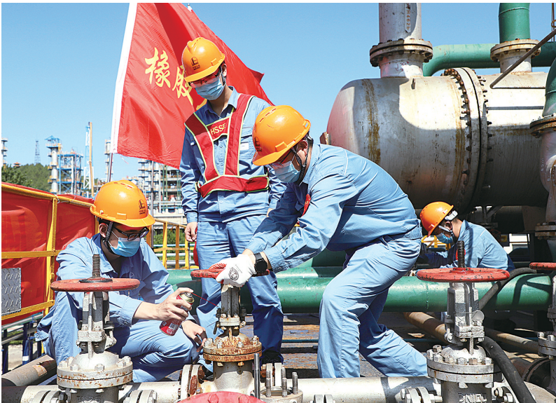
齐鲁石化橡胶装置检修中员工在更换锈蚀阀门。
