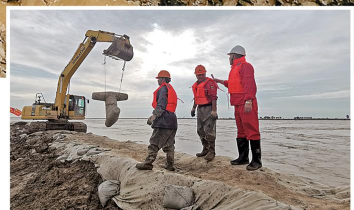
胜大水利分公司动用大型机械吊装扭工字石,加固黄河坝堤。
