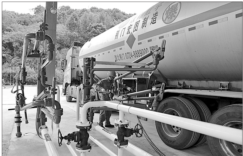
今年以来,巴陵石化进行丁二烯等液化烃装卸栈台建设,在八号沟储运装置汽装班新建8个货位的液化烃装卸车栈台。10月9日,新建丁二烯汽槽(汽车槽车)接卸设施投用。图为10月11日,员工在新投用的丁二烯汽槽装卸栈台接卸丁二烯原料。 彭展 摄
