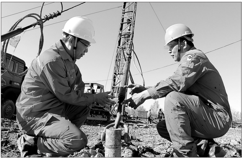
为确保安全生产,胜利油田油气井下作业中心东辛作业区开展“风险再识别、隐患排查”活动,检查施工现场提升系统、用电设施、井控装备等使用规范,针对隐患问题,及时整改落实。图为10月11日,员工检查井架绳结法兰。 毕国平 摄
