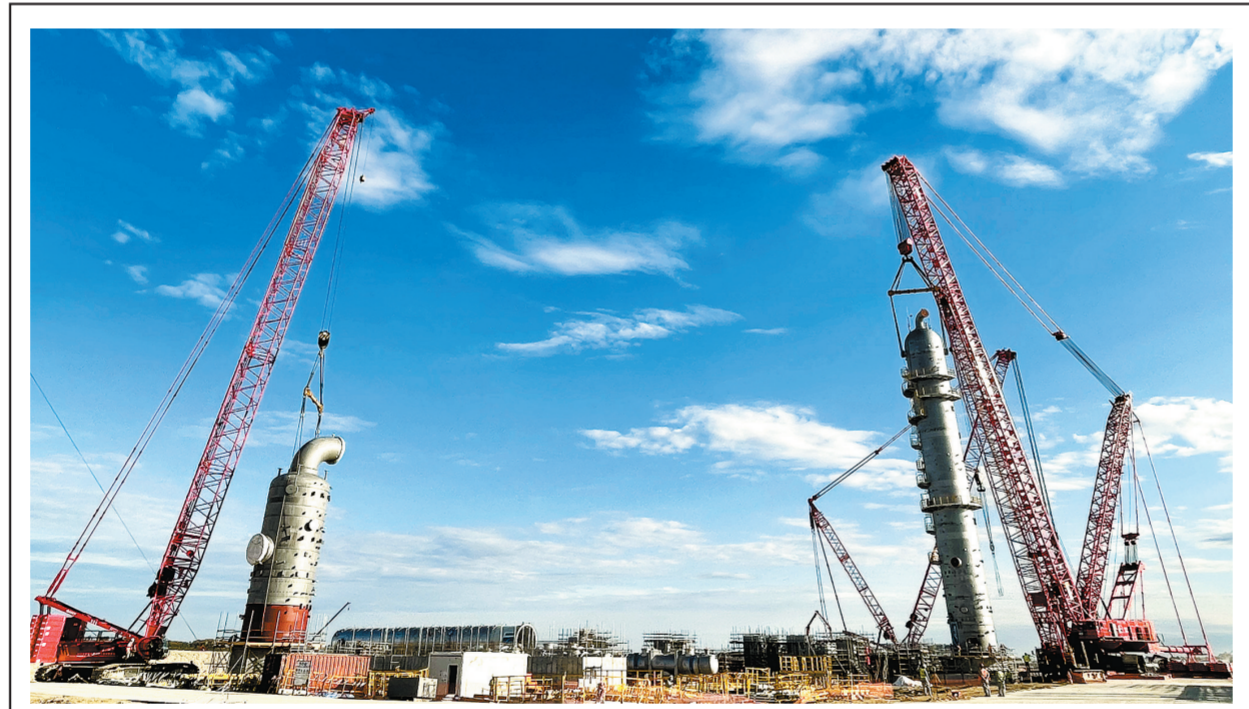
俄罗斯AGCC乙烯项目完成日吊双塔
