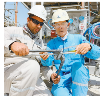
高焕印(右)正在指导坦韦尔煨导压管。 刘光辉 摄
