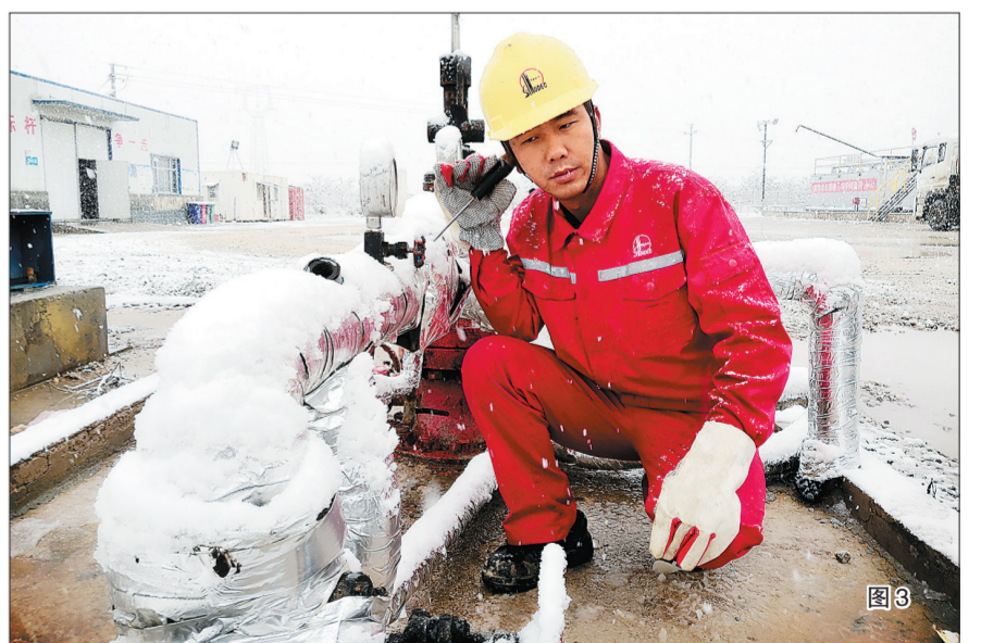
图2:受台风“圆规”影响,广东、海南、广西等地出现大到暴雨,广东石油、茂名石化、海南炼化、广西石油等企业启动应急预案,确保油品充足供应、装置安稳运行。图为10月13日广东深圳石油南宝加油站员工在门店前摆放消防沙袋。 刘海燕 摄 刘科美 张亚培 林鸿冠 张荟 文 图3:10月10日至11日,雨雪天气突袭甘肃庆阳。华北油气分公司采油一厂采油管理一区立即启动特殊天气应急预案,增加高产井、管线等巡查频次,严密监控生产设备,确保生产安全平稳。图为员工冒雪查看井口设备。 刘新颖 摄 张家瑞 文
