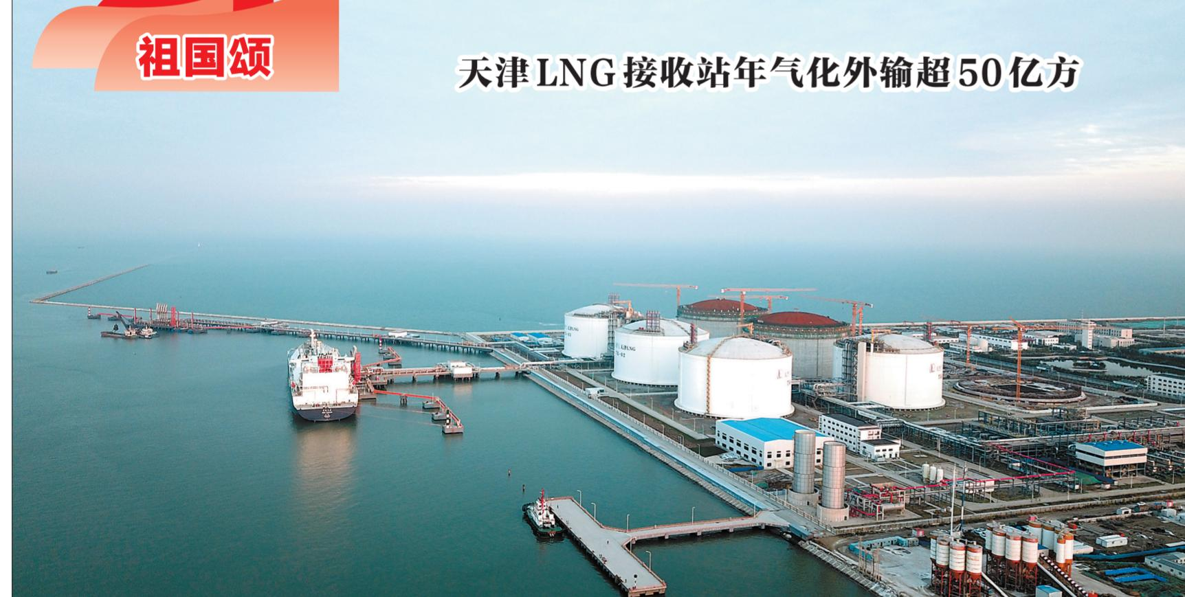
截至10月13日,天然气分公司天津LNG接收站今年气化外输天然气超50.8亿立方米,为华北地区能源供应奠定坚实基础。2号码头投产后,天津LNG接收站接卸能力将达到1080万吨,成为国内首个超千万吨级LNG接收站。图为天津LNG接收站双码头,其中2号码头配套工程目前正在收尾中,预计11月中旬具备投产条件。 王军 摄
