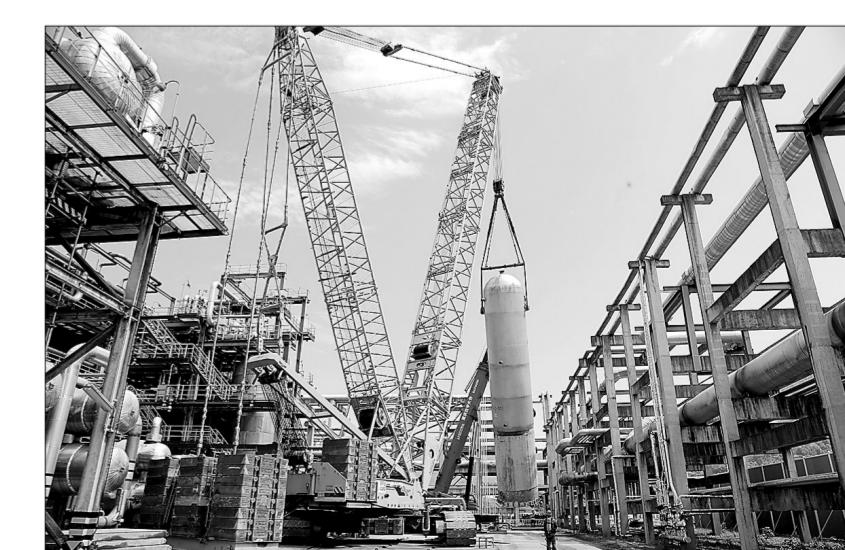
日前,中原油建负责施工的普光气田净化厂第一联合装置一级主吸收塔拆除完成。设备周边容器管线交错,空间位置狭小,作业风险高。该公司采用500吨履带式塔吊,在300吨的轮式吊车配合下顺利将设备从联合装置内吊出,运离施工现场,完成普光净化厂以来首次一级主吸收塔拆除任务,为今后同类设备塔器的施工积累了经验。图为吊装拆除现场。
