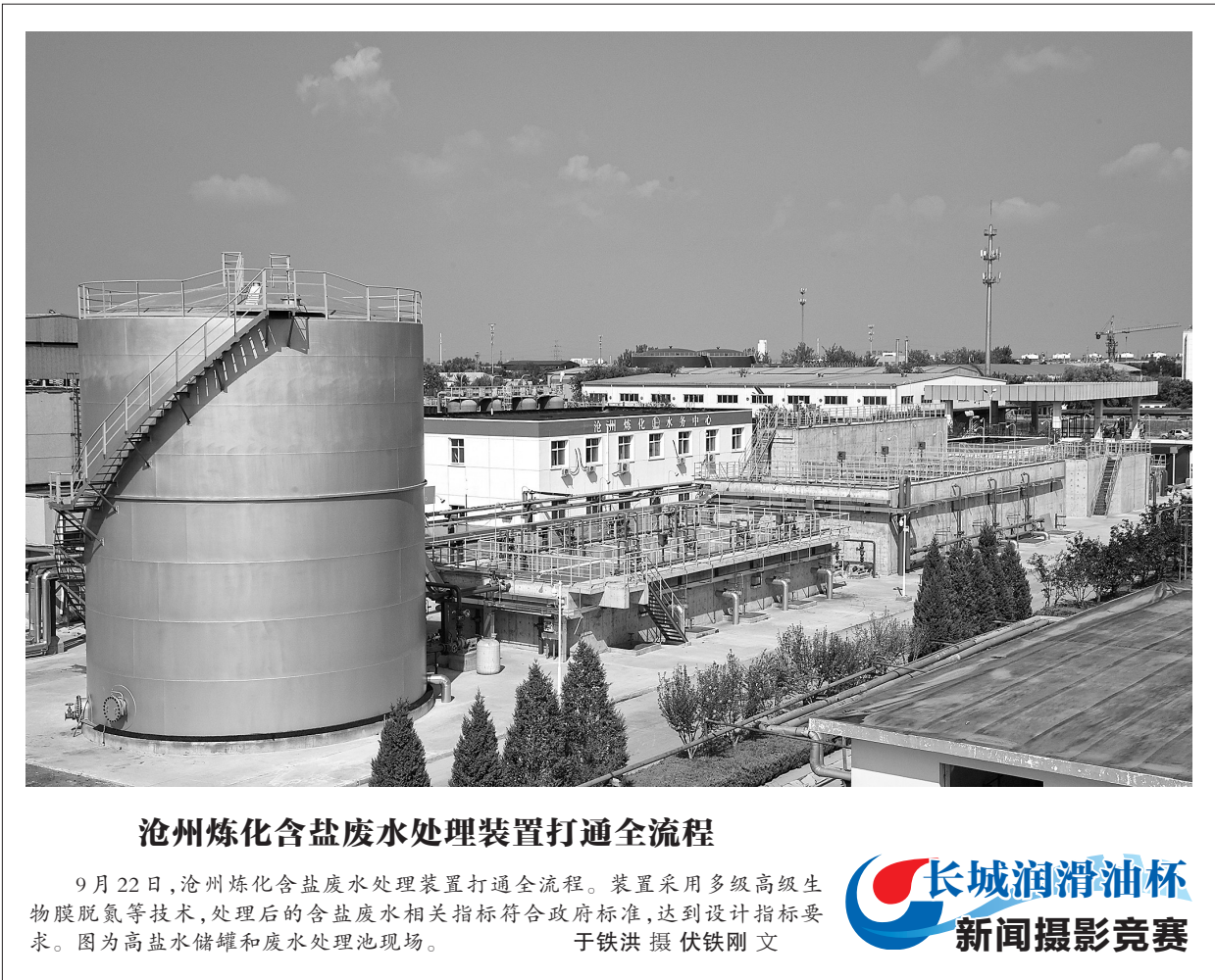
沧州炼化含盐废水处理装置打通全流程 9月22日,沧州炼化含盐废水处理装置打通全流程。装置采用多级高级生物膜脱氮等技术,处理后的含盐废水相关指标符合政府标准,达到设计指标要求。图为高盐废水储罐和废水处理池现场。 于铁洪 摄 赵铁刚 文
