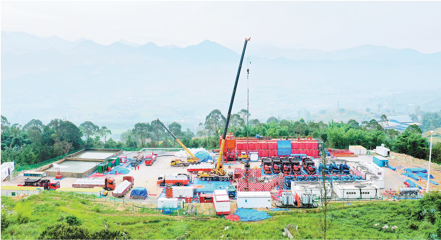
中国石化加大页岩气勘探开发力度。图为8月15日,华东油气在重庆南川页岩气田完成深层页岩气风险探井胜页5HF井分段压裂施工场景。
