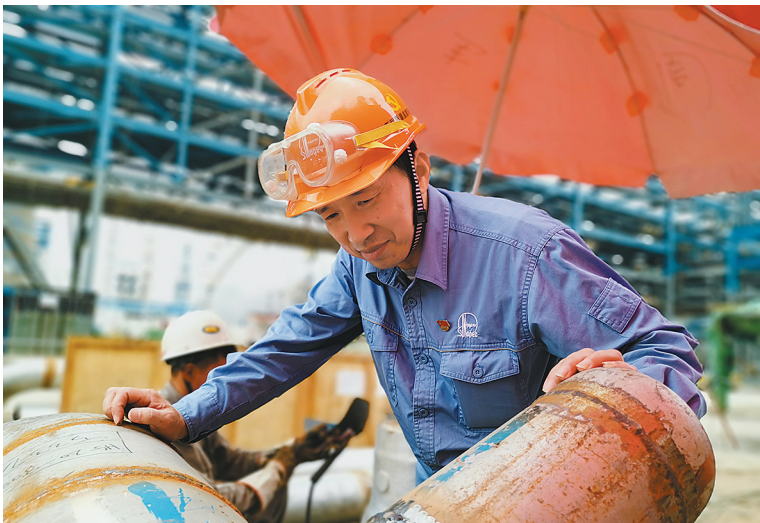
宁波监督站党支部书记、副站长胡联伟在项目现场检查不锈钢管道焊口质量情况。 黄凯摄
