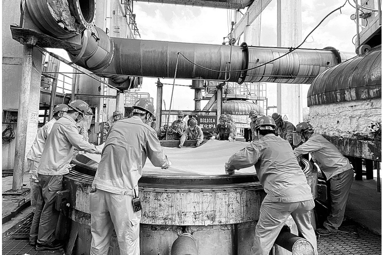
图为南化公司煤化工部组织员工更换硝酸氧化炉铂网。裴昱摄
