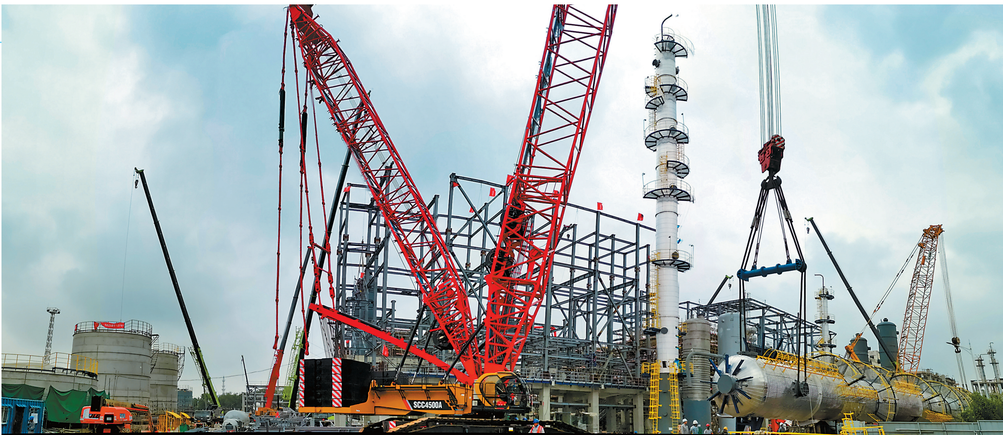
直径8米、高度22米、重量170吨的C-105氧化液提浓塔准备吊装。
