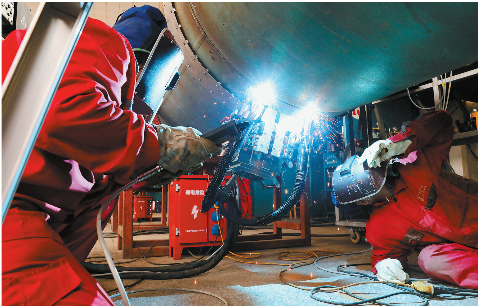
施工人员使用全自动焊接技术提升工程建设质量和效率。
