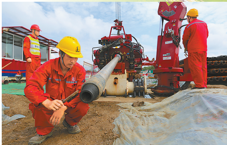
在新沭河穿越施工现场,员工对钻杆进行清洁保养,以保证定向钻施工顺利进行。
