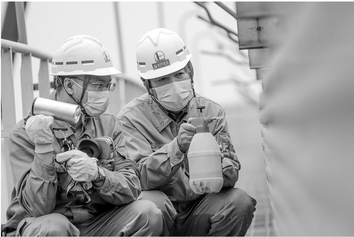
燕山石化催化裂化装置员工为“三废”空冷设备打压试水治理侧漏隐患。
