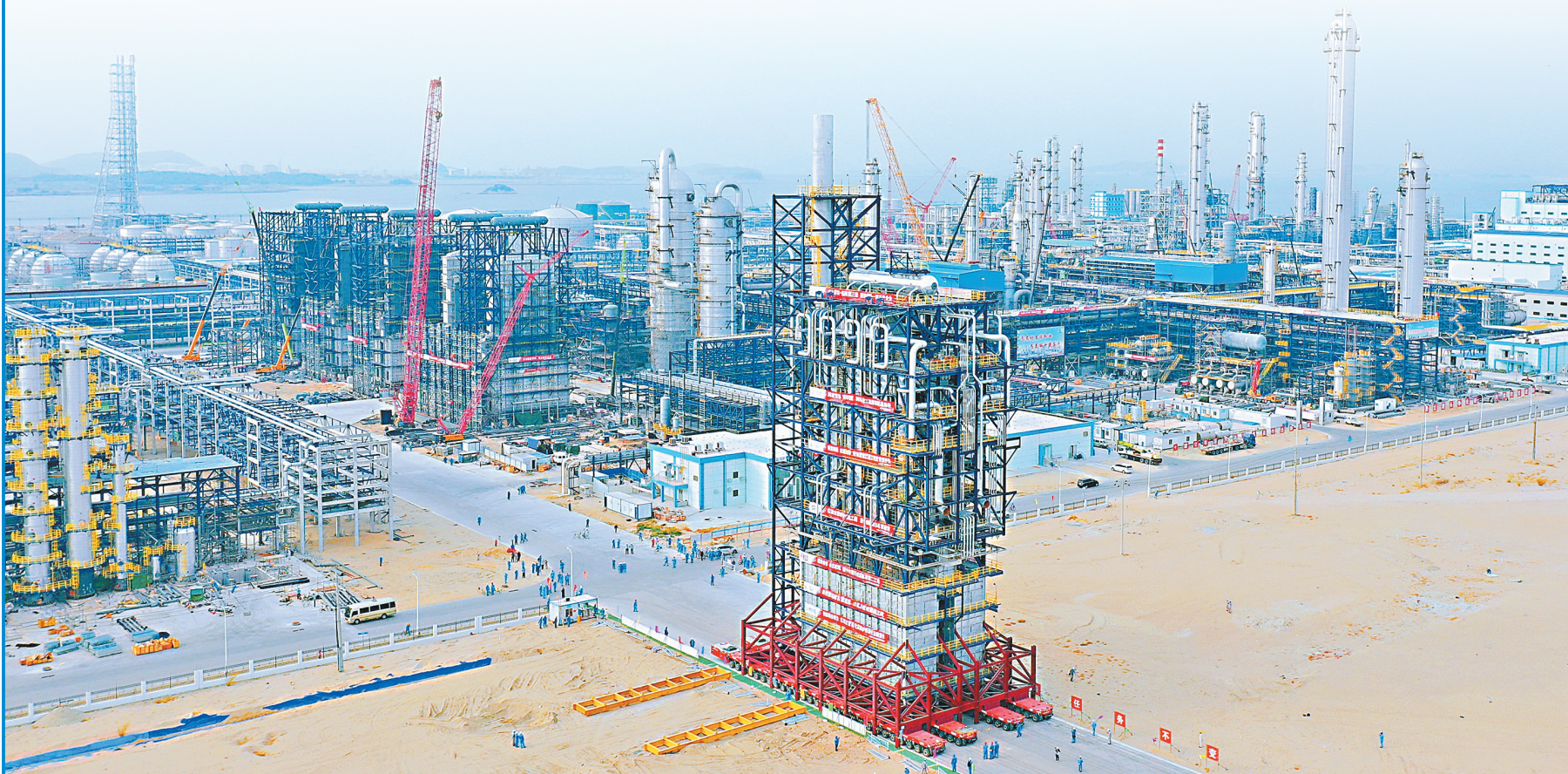
2020年10月30日,国内首台整体模块化乙烯裂解炉搬运完成。
