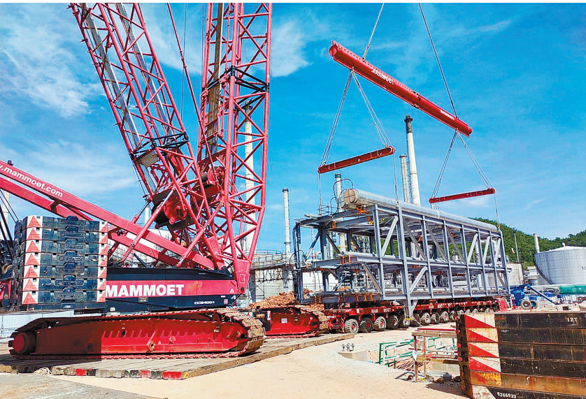
左图:自动焊班长指导泰籍员工学习自动焊接技术。右图:模块化安装理念让钢结构安装“进度条”快速拉进。
