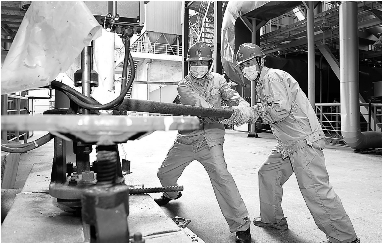
江汉盐化工员工正在调节锅炉给水管阀门。 李占军 摄
