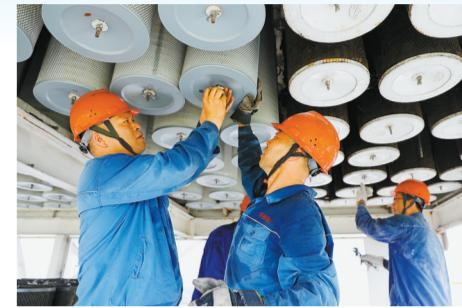
入伏后,中安联合以保障夏季安全生产为重点,认真做好防暑、防雷、防汛工作,狠抓现场直接作业环节安全监管,严格落实作业人员劳动保护措施,坚决杜绝违章行为,保障员工身体健康;对大机组及重点设备进行特护,及时消缺,保证装置稳定运行。图为7月15日,作业人员在空分装置更换空气过滤器过滤桶。赵天奇 摄
