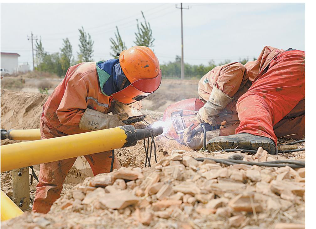
7月4日,高温炙热下,胜利油田地面工程维修中心河口维修服务部管网维修二站员工在更换单井油、掺水管线,确保施工进度。
