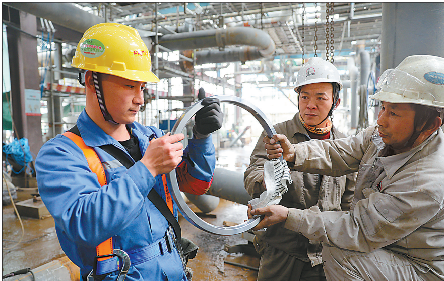
在加氢裂化装置区,工作人员精心检查法兰密封面,确保安装作业顺利进行。该装置由洛阳工程公司总承包、五建公司负责施工。 程宇晓 摄
