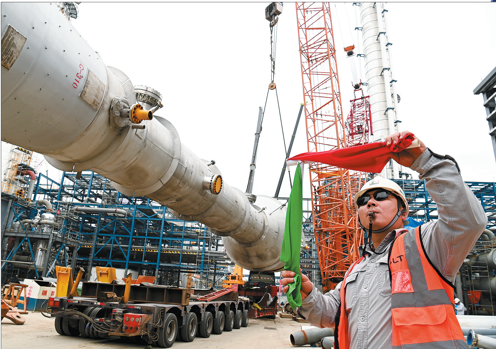
6月21日,起运公司开展C-310碳二洗涤塔400吨履带吊吊装作业。该工程由工程建设公司承包、十建公司等单位进行施工。 胡庆明 摄
