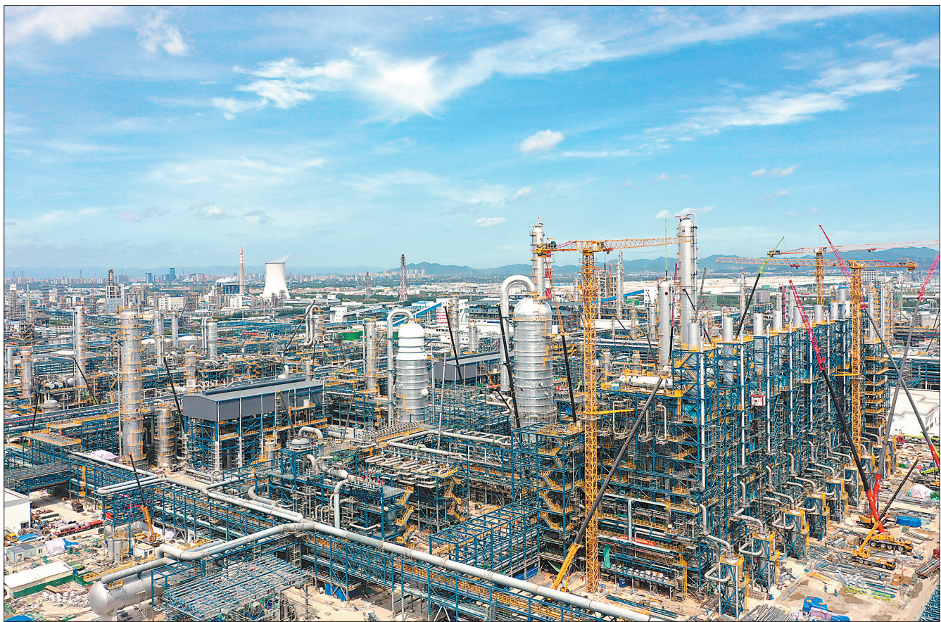
7月6日,由工程建设公司总承包、十建公司施工建设的120万吨/年乙烯装置,有序开展乙烯三机核心设备调试、动设备试车及工艺管道尾项施工。 华赞 摄
