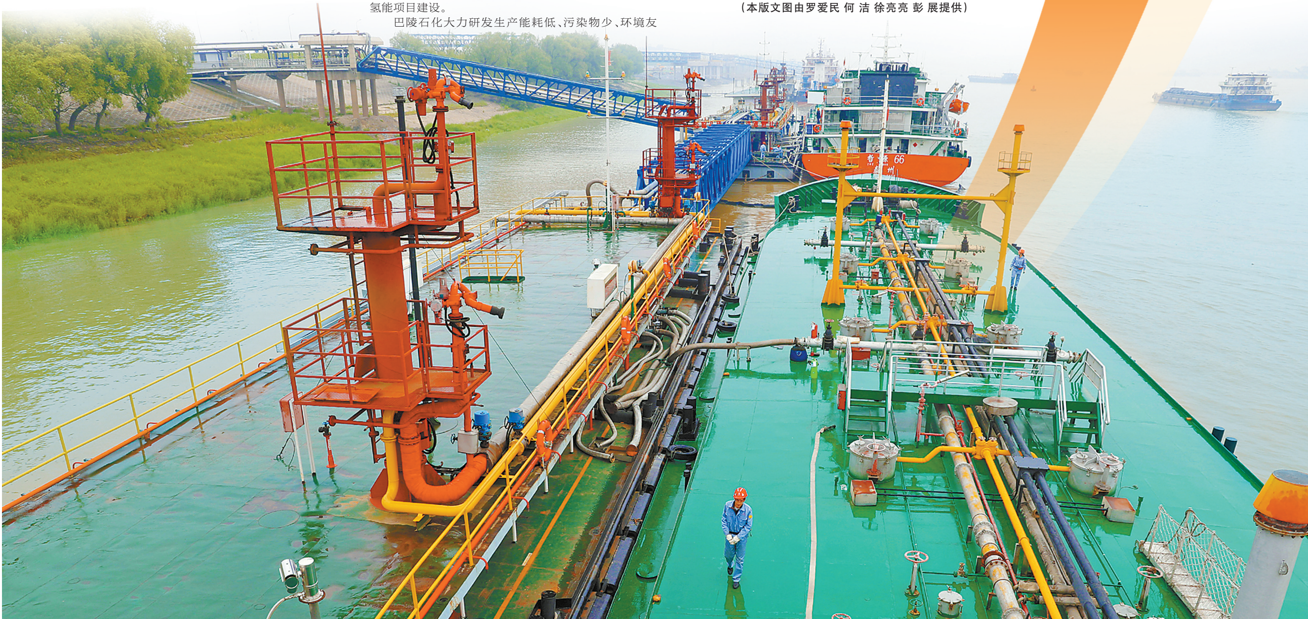
位于长江白尾段的巴陵石化码头及罐区新建一套采用“低温吸收+膜分离+吸附”工艺的VOCs气体处理装置及配套罐组,油气去除率不低于97%。
