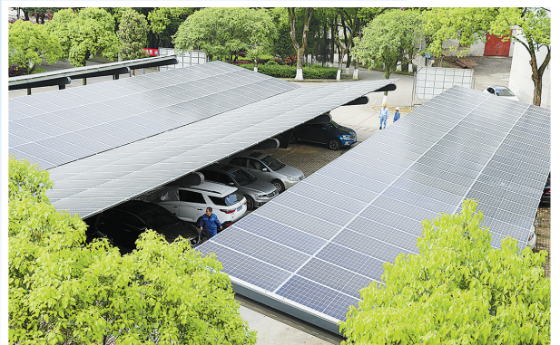
公司首个光伏电站车棚光伏发电站年发电量可达13.8万千瓦时,为办公场所和相关装置提供用电。
