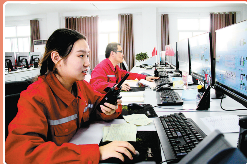
东胜气田及集气站中控室。
