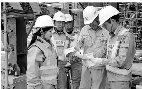
在镇海基地“文明施工大家行”劳动竞赛中,安全网格长检查现场施工票证的符合性。 华贵摄
