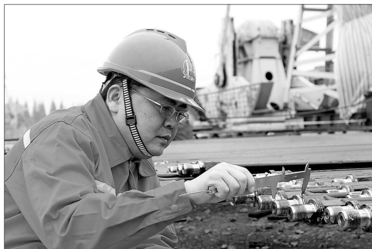
吴继农在施工现场测量抽油杆螺纹长度。 宋国梁 摄
